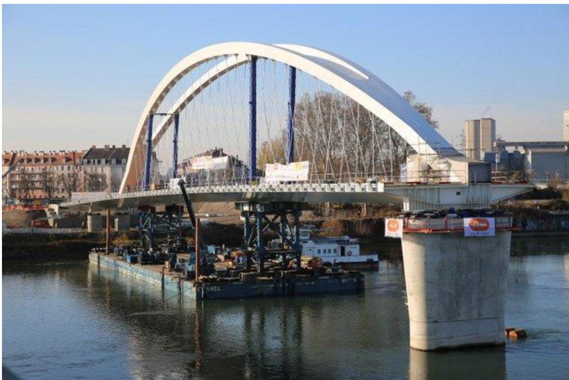
*Le tablier France positionné au-dessus de ses appuis mardi 8 décembre 2015 (pile centrale au milieu du Rhin, piles sur berge et culée).* © AIRDIASOL.Rothan
