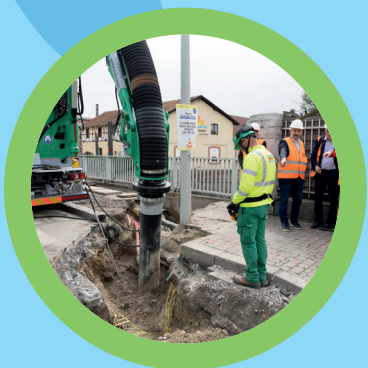
POURSUITE DES TRAVAUX DE L'EXTENSION DU TRAM F À L'OUEST
